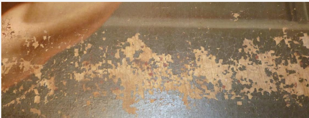
Lacunes à combler au mastic avant d'être retravaillées.
