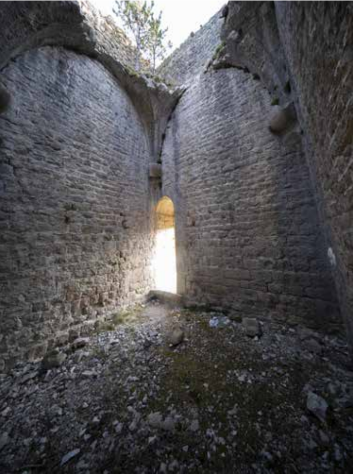
l'intérieur depuis le nord ouest
