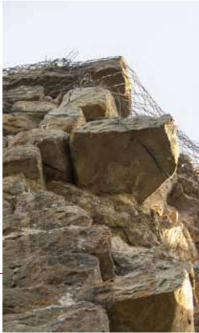
arrachement d'angle
