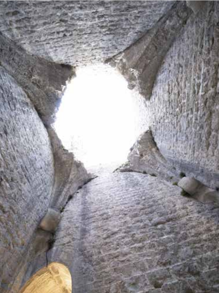
le rest de voûte
