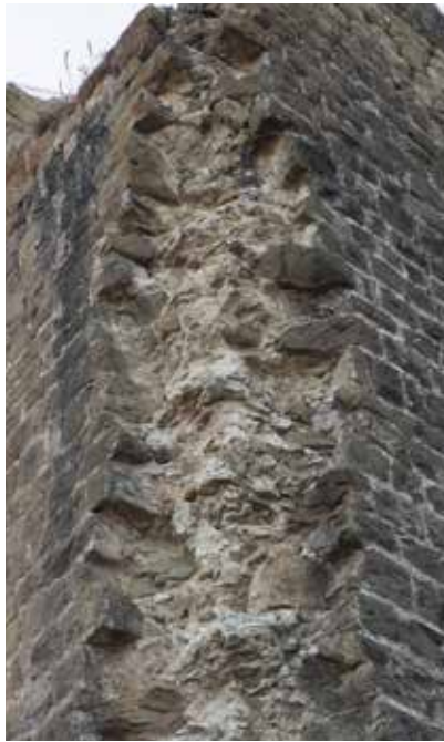
arrachement d'angle
