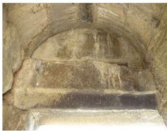
Tympan et linteau de la porte d'entrée
