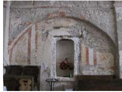
Arc doubleau dans le mur de la nef
